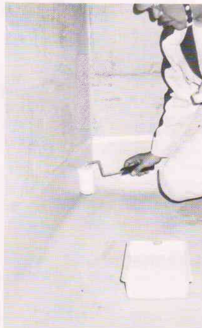
ローラー塗による塗装
